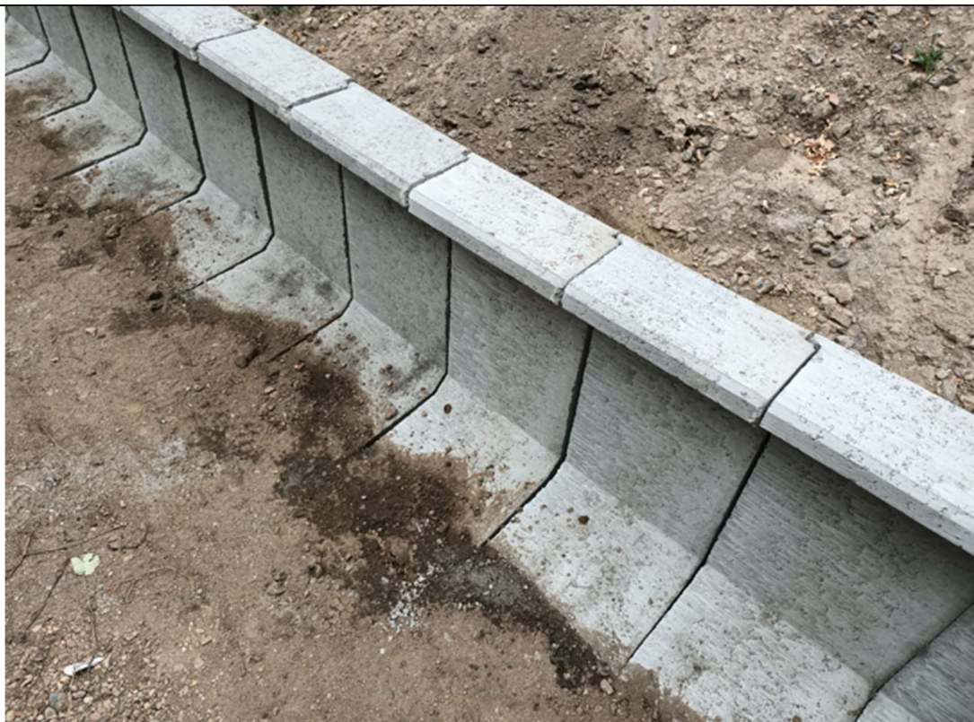
Foto. 7. Ul. Ślężoujście , druga dekada czerwca 2023 r. (montaż stałych wygrodzeń herpetologicznych u podnóża skarp).
