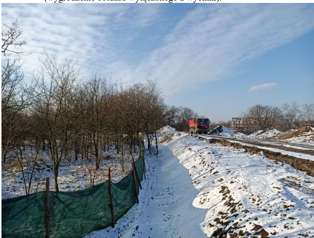
Foto. 4. Ul. Ślężoujście , stan w drugiej dekadzie grudnia 2022 r. (wygrodzenie terenu budowy).
